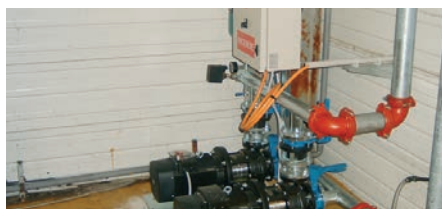
Mise en place de surpresseurs sur réseau "Eau de ville"
