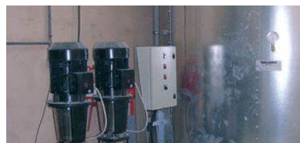
Mise en place de réserve d'eau surpressée autonome
